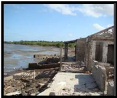
Figura 5.31. De izquierda a derecha: Playa Larga, (Cárdenas), Nazabal y Jáquete. Sector costero muy antropizado y severamente dañados por el impacto de eventos erosivos extremos.
