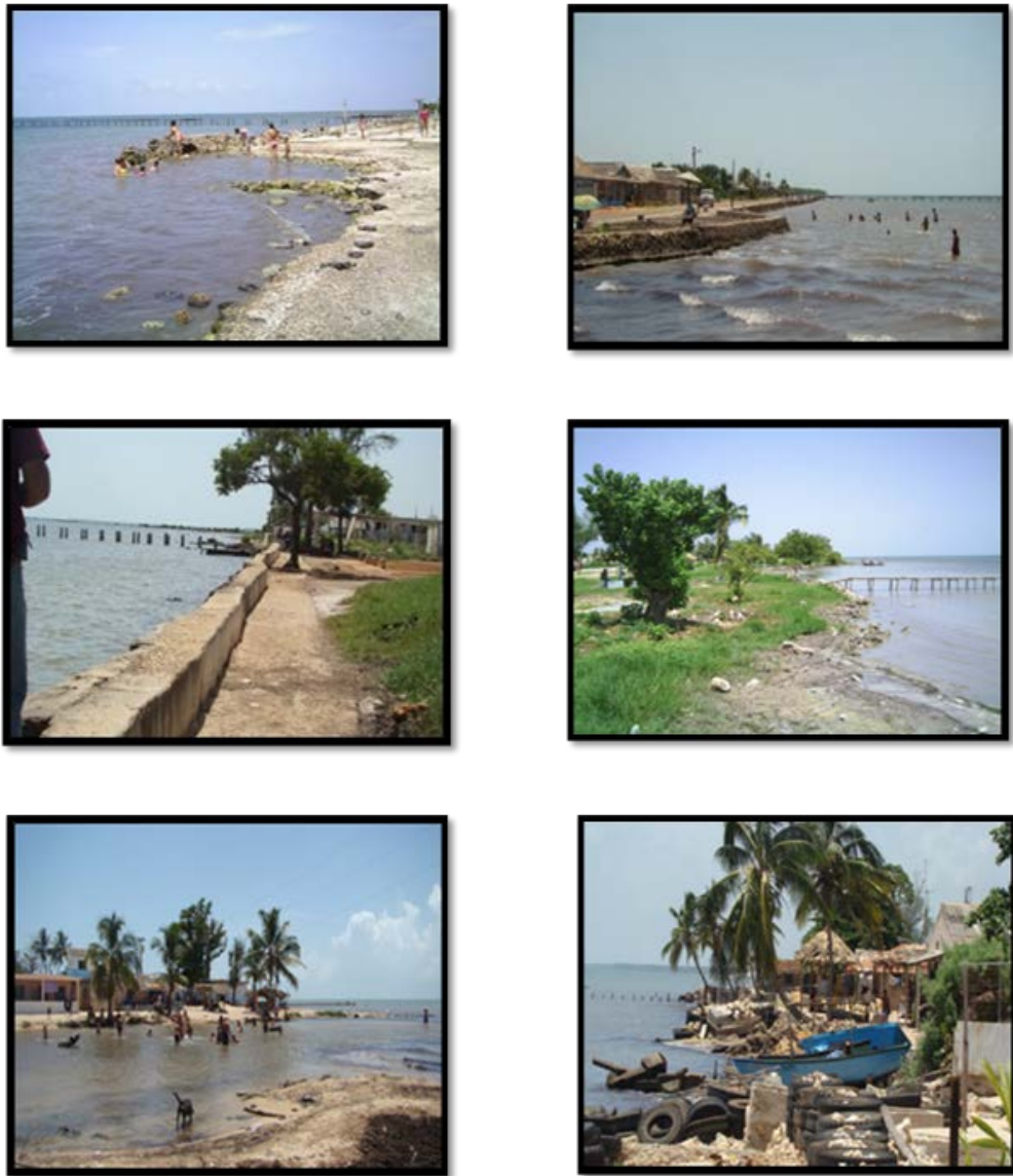
Figura 5.27. Ejemplos de sectores costeros del sur de las provincias Artemisa y Mayabeque: (a) Playa Guanimar. Sector costero muy antropizado y severamente dañados por el impacto de los huracanes Ike y Gustav en el 2008; (b) Playa Cajío. Sector costero muy antropizado y severamente dañados por el impacto de los huracanes Ike y Gustav en el 2008 y (c) Zona de baño en la desembocadura del río Mayabeque y sector Oeste de la Playa Mayabeque muy antropizado y severamente dañados por el impacto de los huracanes Ike y Gustav en el 2008.
