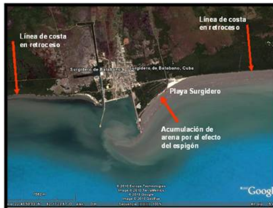
Figura 5.28. Playa de Surgidero, mantenida por la acumulación al lado este del espigón del puerto (imagen satélite del Google de agosto del 2009).
